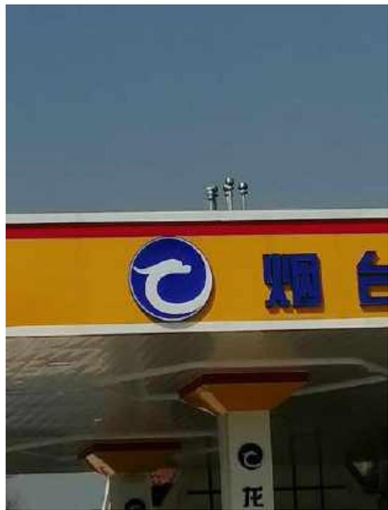
三次油气回收系统排气管（罩棚上方）
