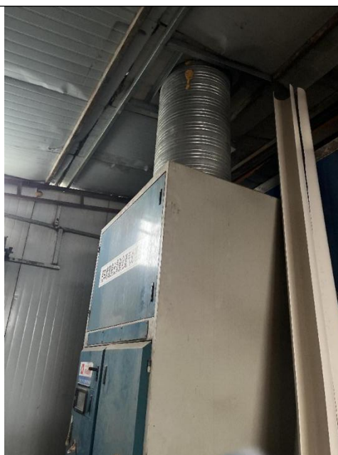
图 8-2 “过滤棉+UV 光氧+活性炭”装置 (1#)
