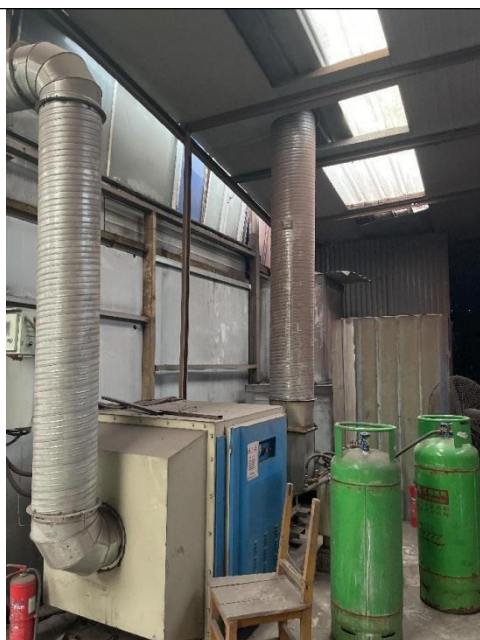
图 8-1 “过滤棉+UV 光氧+活性炭”装置 (2#)
