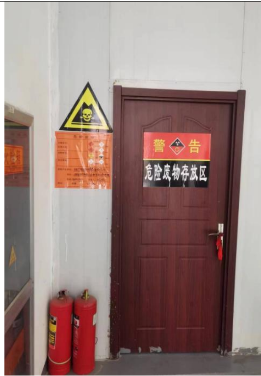
危险废物暂存间外部
